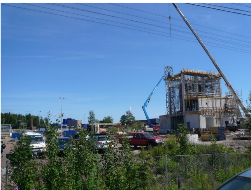
Mussalossa hankealue sijaitsee teollisuusalueella. Puhdistamon saneerauksen ja linkotornin rakennustyöt ovat meneillään.
